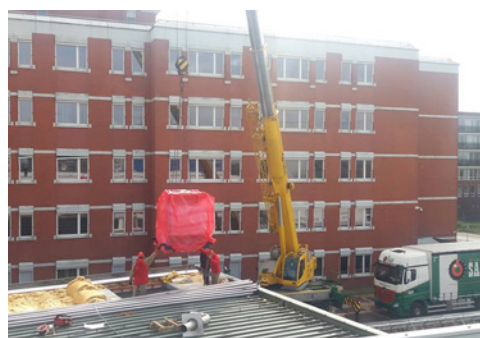
Het verwijderen van de MRI-scanner van MC IJssmeerziekenhuizen
